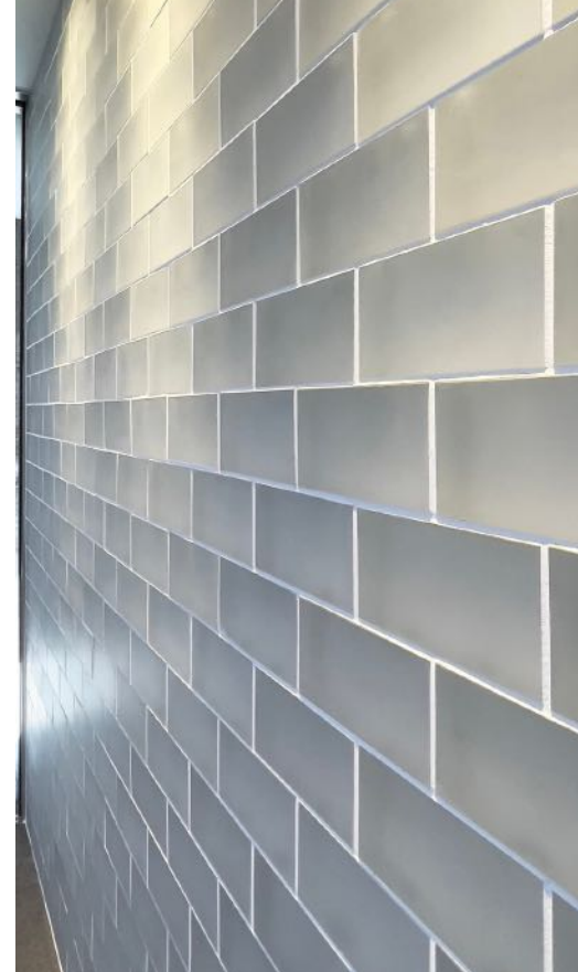
※Bタイプ(マット) 目地10mm 施工例
